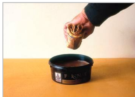
Étape 6 - Si vous voulez, vous pouvez augmenter la résistance de la surface en appliquant Cera del Vecchio.
