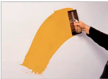
Étape 3 - Première Couche, répartir librement le produit avec la truelle.
