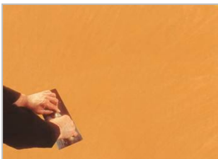
Étape 5 - Lorsque le produit commence à sécher procéder à la compression et aux phases de polissage.
