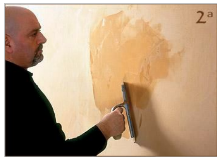
Étape 4 - Deuxième Couche, répartir librement le produit avec la truelle.
